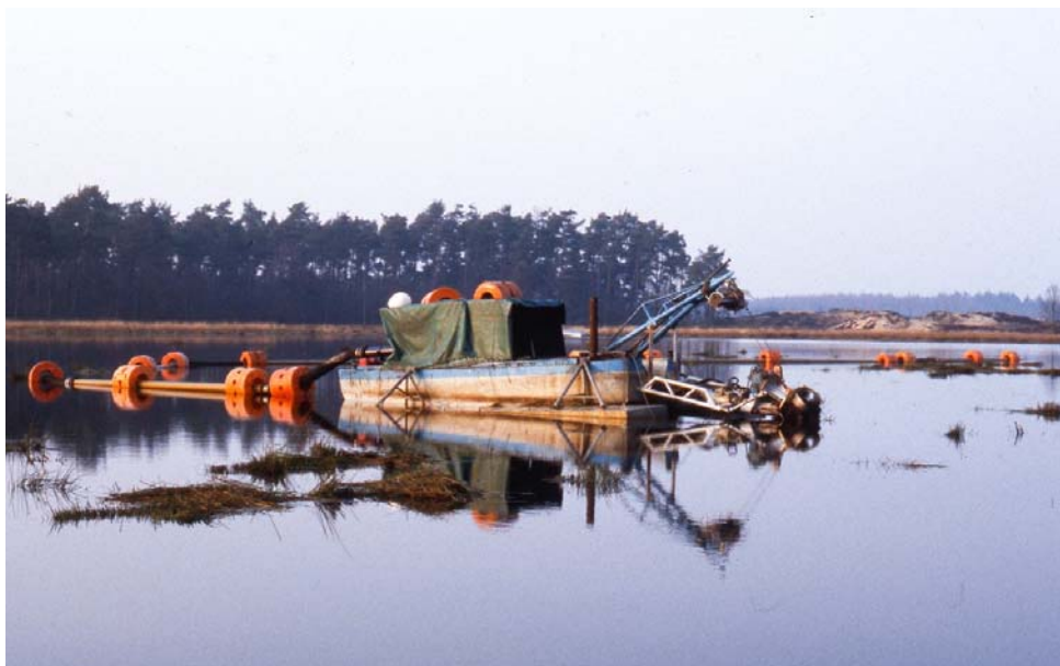
Figuur 160 Baggerwerk in de Grenspoel in 1992 (foto: G.W. de Vries).
